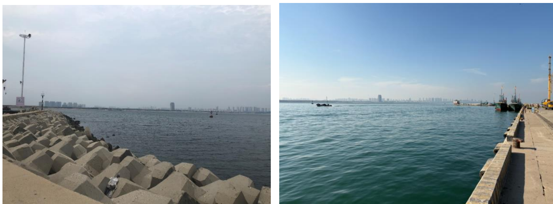
图 4.1-18 中心渔港码头西现状图
